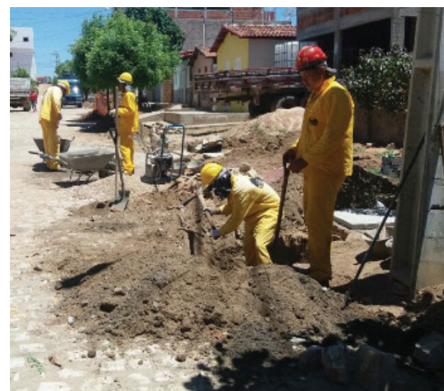
As ligações à rede de esgoto estão sendo feitas desde o início da semana
